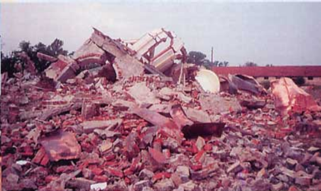
The church after blasting / Храм после взрыва.
