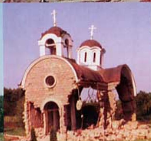
The church after first mining Церковь после первого взрыва
