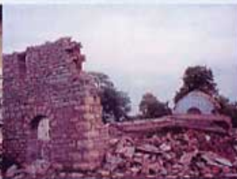
The church after destruction Храм после разрушения.
