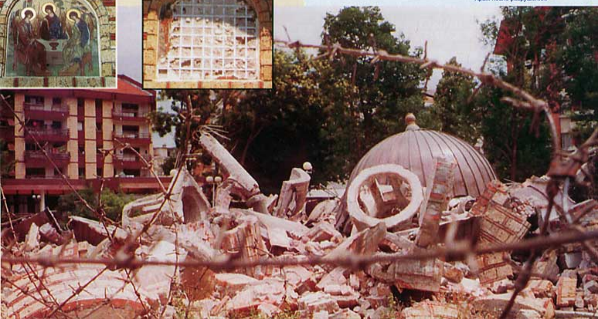
The church after destruction Храм после разрушения.
