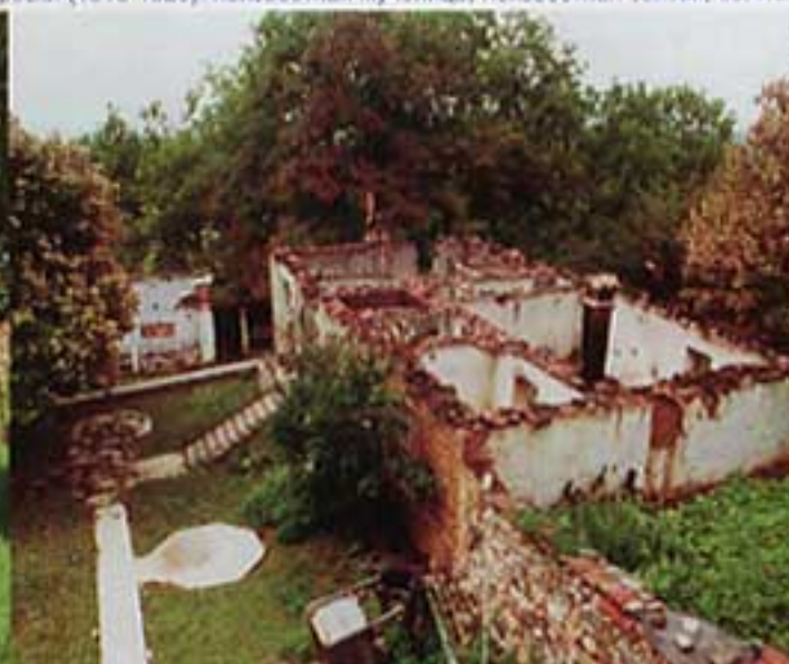
The vicarage destroyed by fire / Сожжённый приходской дом
