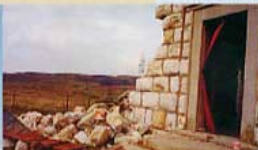
Blasted entrance Взорванный входной портал
