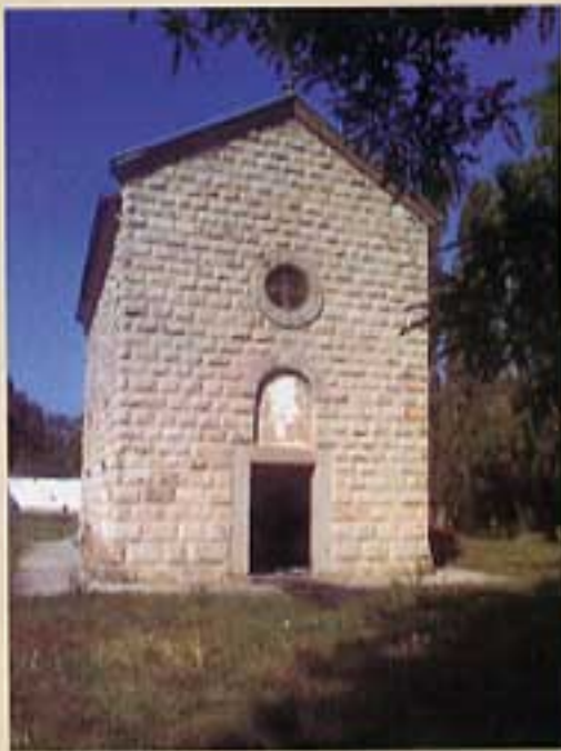
The outside view of the vandalized church Внешний вид разрушенной церкви.
