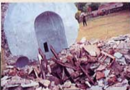
The church after destruction Храм после разрушения.
